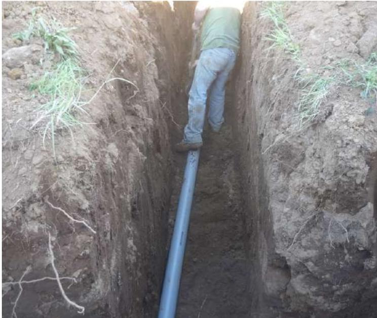
Perforaciones para sistema de ventilación con pozo provenzal o canadiense
